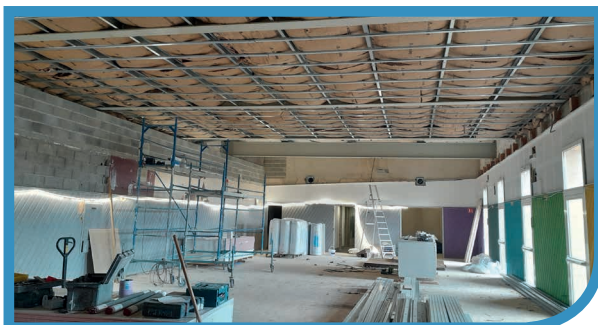
Isolation sous les logements
