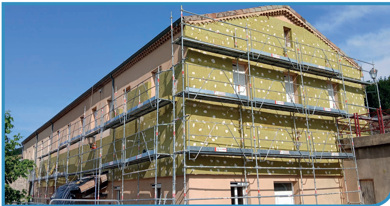
Mise en place isolation façade est et sud
