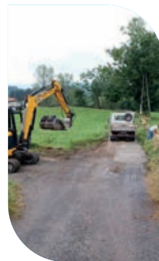
Réparation route de La Marette
