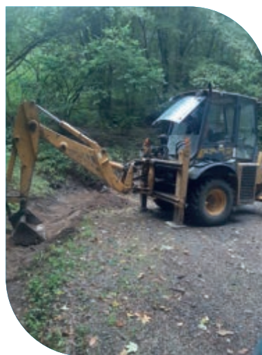
Restauration des fossés rte de Chalan
