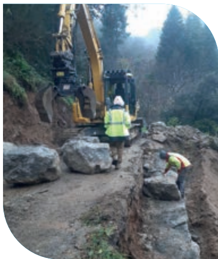
Travaux urgents route de Geys
