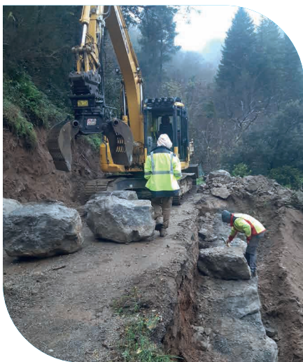
Travaux urgents route de Geys
