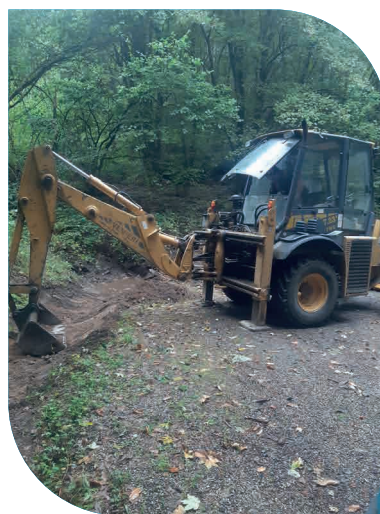
Restauration des fossés rte de Chalan
