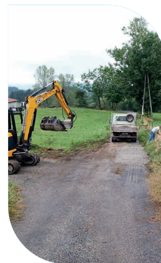
Réparation route de La Marette
