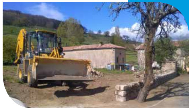
Travaux Maison Serre
