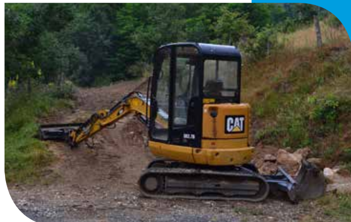
Travaux extension d'eau le Pral
