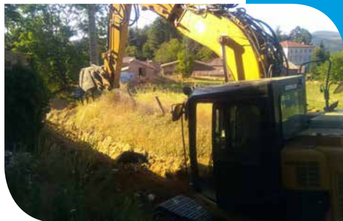
Travaux extension d'eau Plos
