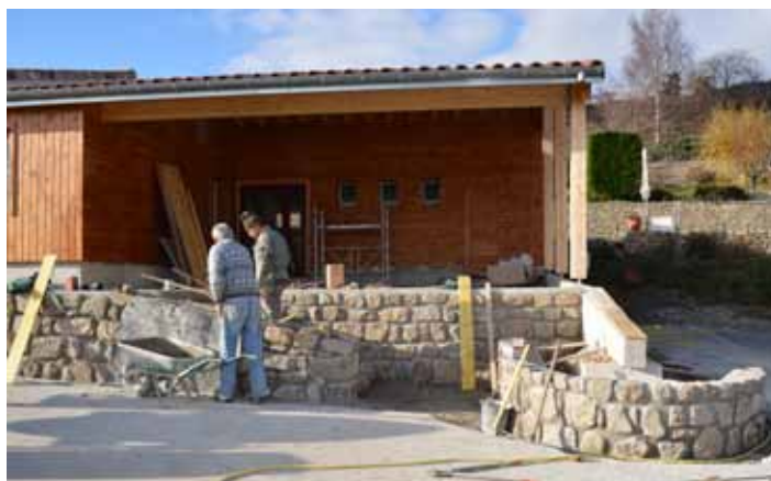
Vincent et François sur le chantier de la nouvelle école
